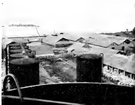
Installations Lever frères.
